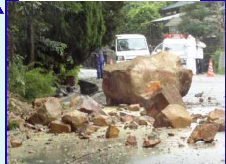
花の峯 (法面崩壊による落石)
