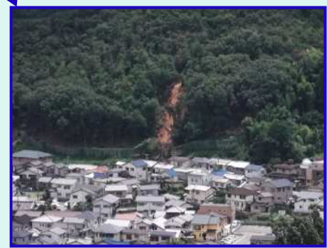
生瀬町2丁目 (急傾斜地の崩壊)
